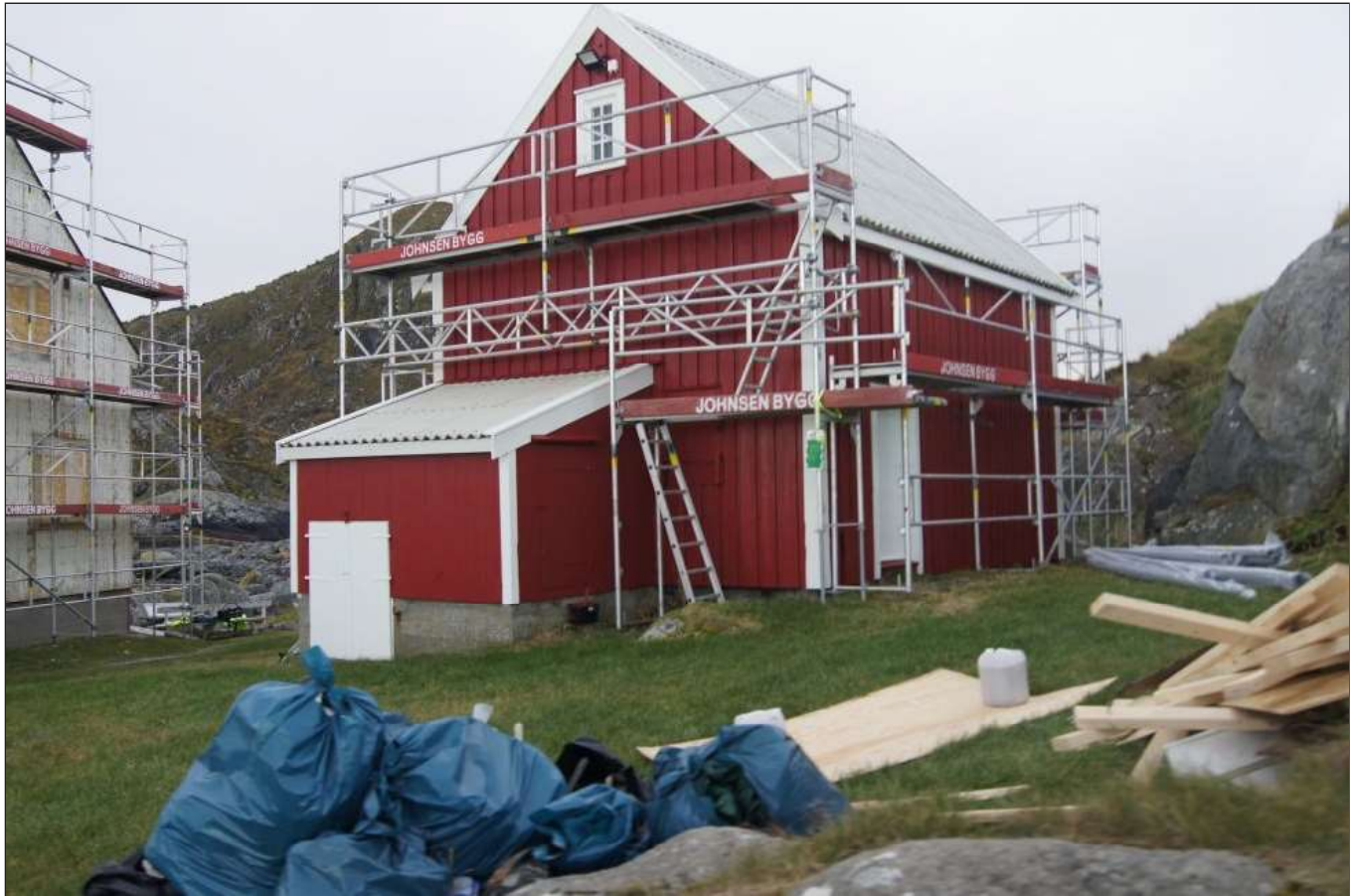
Fjøsbygninga, ei av dei originale bygningane som har fått «ytre» hjelp etter alle kunstens reglar. Foto: Sigrun Rogne
