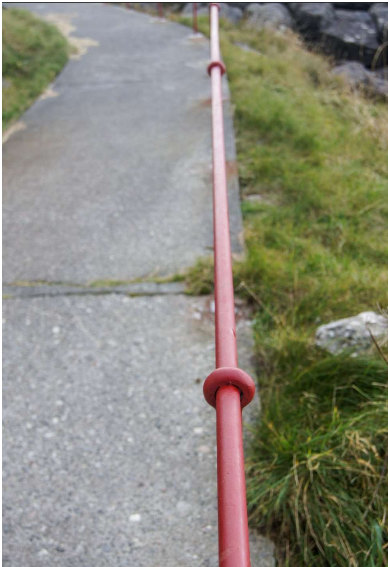
Nytt og gammalt smijernsrekkverk. Det nye laga av Myhre Smie. Foto: Sigrun Rogne
